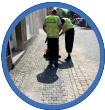
VERLEGUNG VON PFLASTERSTEINEN I
