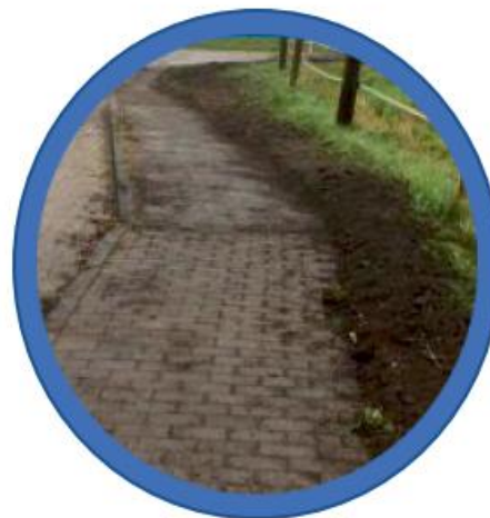
NIVELLIERUNG DER OBERFLÄCHE
