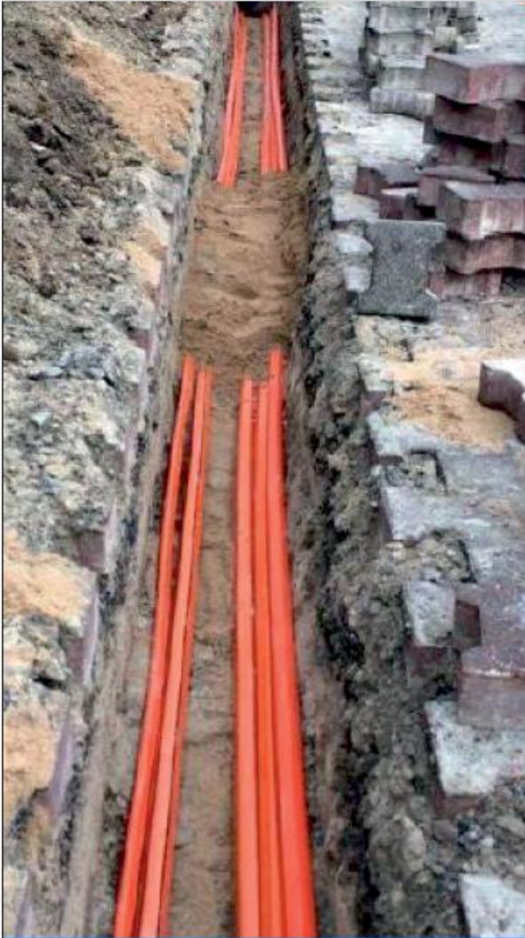
Verlegung von Glasfaserkabeln
