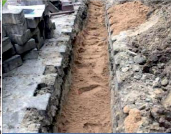
Schutz von Glasfaserkanälen
