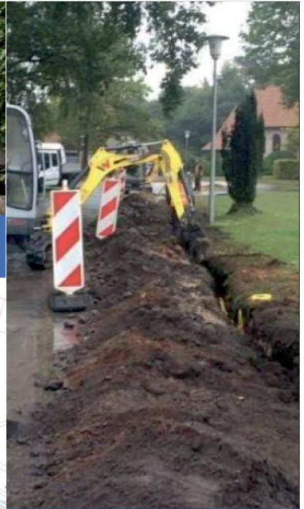
Aushub bis zu einer bestimmten Tiefe
